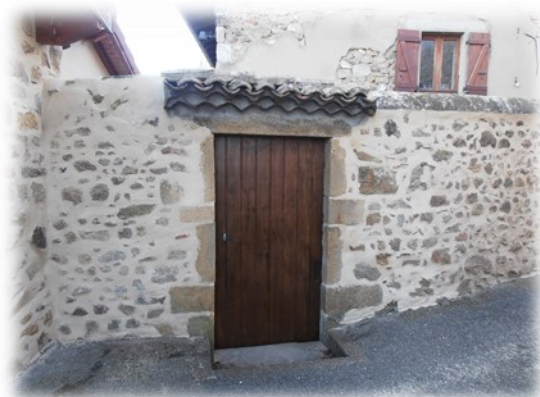
Reprise d'un mur délabré
