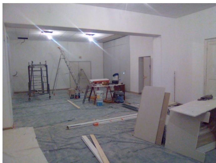
Auparavant, une salle vieillissante ...
