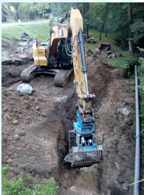
Travaux MONTAGNIER TP
