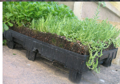
Exemple de toiture-terrasse végétalisée et bacs pré-cultivés
