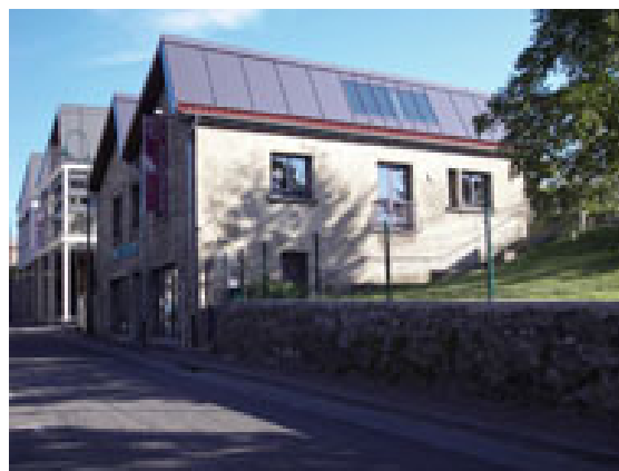
Exemple de toiture en shed
