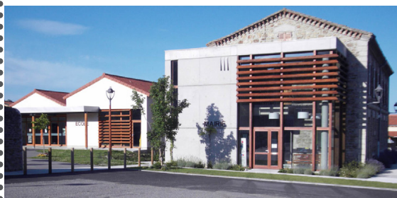
Exemple de lames orientées fixes
